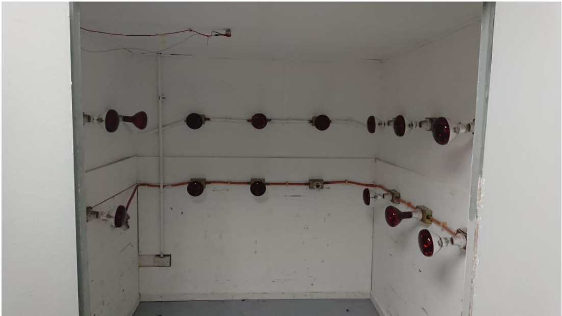
Figura 3-11 Interior horno taller de toboganes y balsas.
