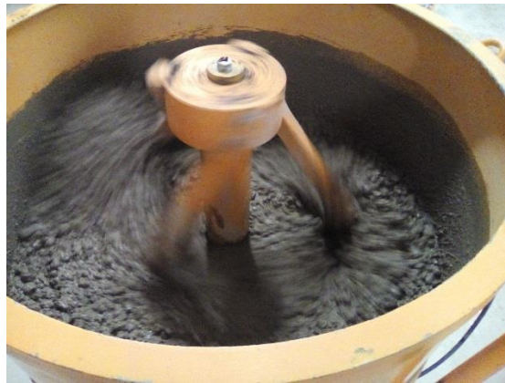
Figura 100 Mezclado de hormigón
