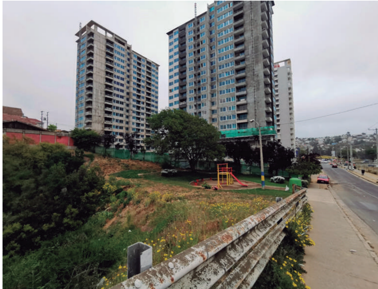
Edificio en Construcción, Santa Julia, 2020. Fuente: Elaboración propia.
