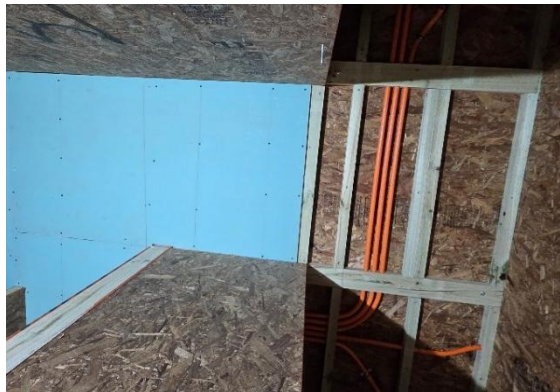
Figura 15. Vista desde abajo al techo del cielo falso. FONDEF ID25I10634. 2025.
