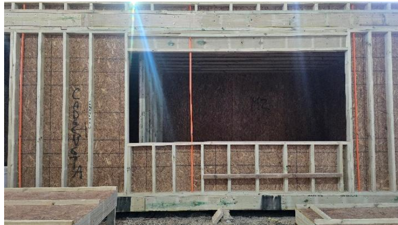
Figura 17. Canalizaciones temporales en lado longitudinal del módulo. FONDEF ID25I10634. 2025.
