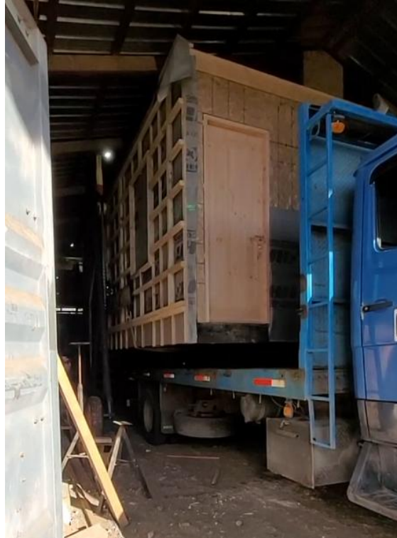
Figura 18. Montaje de módulo a camión. FONDEF ID25I10634. 2025.
