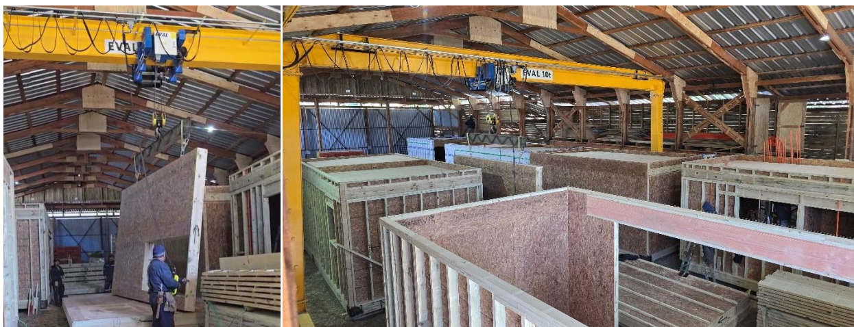
Figura 14. (Izquierda) Izaje de un panel de piso con el puente grúa. (Derecha) Módulos en distintas etapas de construcción. FONDEF ID25I10634. 2025.
