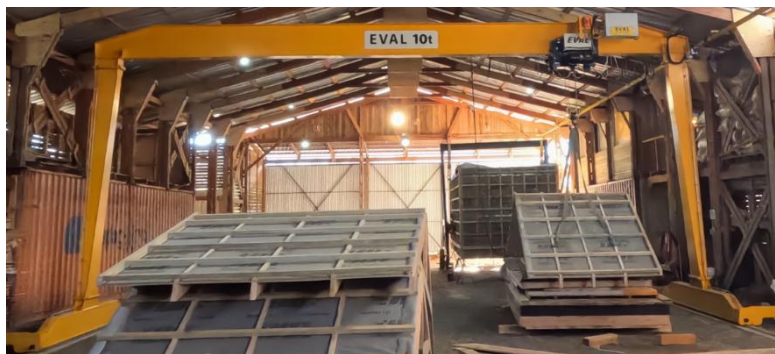
Figura 10. Puente grúa de la prefabricadora Iglú. FONDEF ID25I10634. 2025
