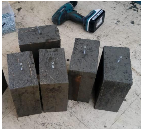
Fotografía 2-27. Moldajes interiores extraídos. Fuente: Propia
