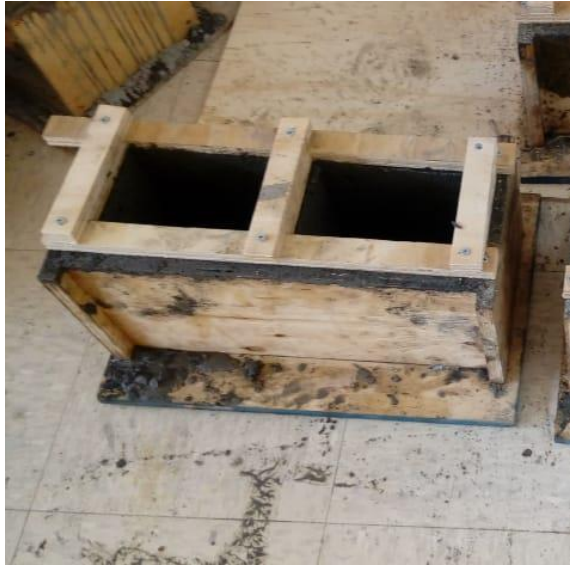
Fotografía 2-28. Bloque convencional con moldaje auxiliar. Fuente: Propia
