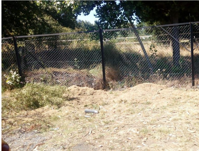
Fotografía 4-3. Cerco perimetral existente, zona posterior. Fuente: Propia.
