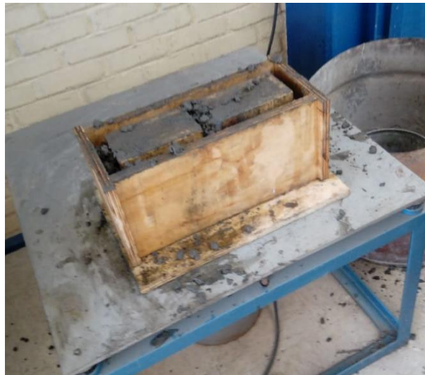
Fotografía 2-25. Vibrado del hormigón.
