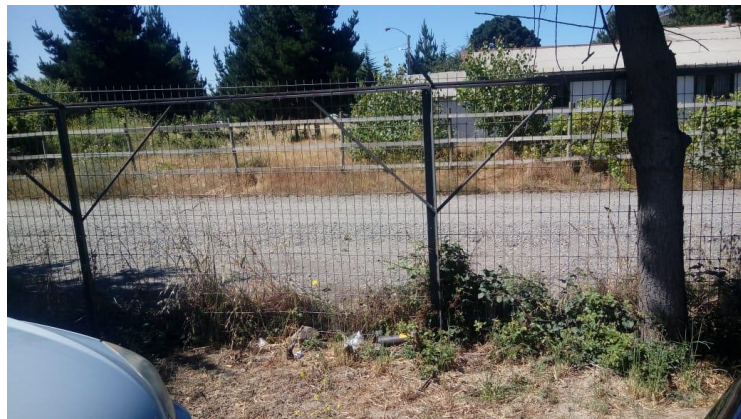
Fotografía 4-2. Cerco perimetral existente, zona media. Fuente: Propia.
