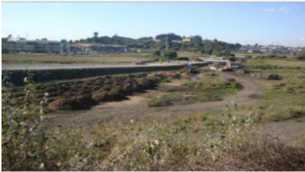
Ilustración 3-36: Carretera que atraviesa y fragmenta el humedal Paicavi, la cual además lleva consigo continuos procesos de rellenos que van reduciendo el humedal. (Foto: S/A. S/F)
