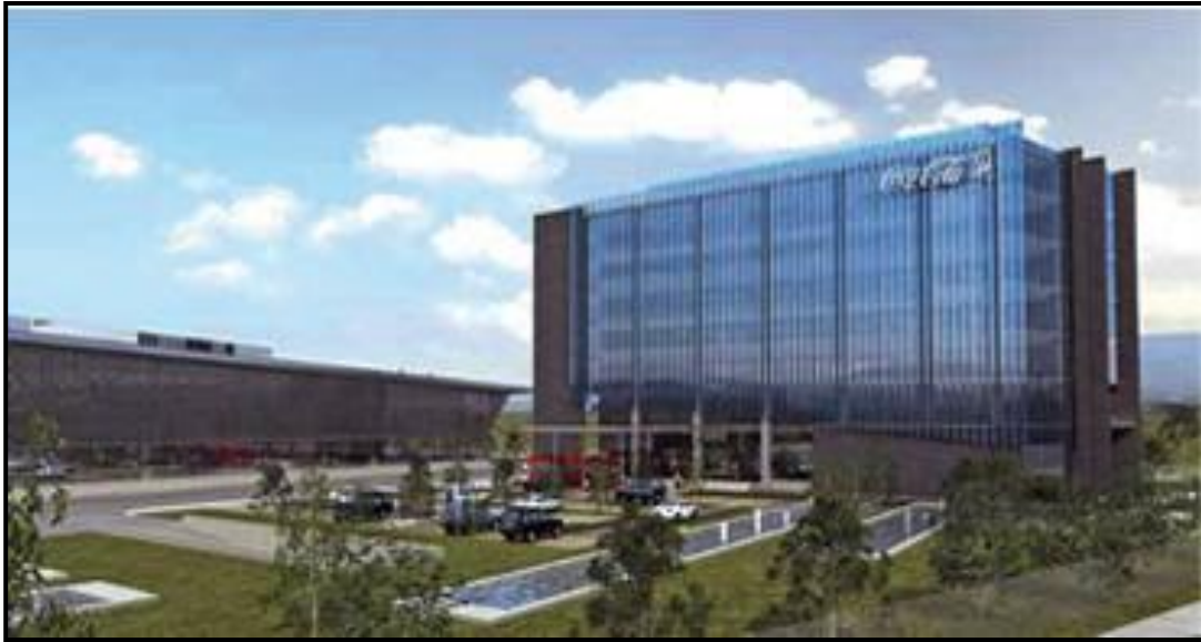
Figura N° 2. Edificio corporativo y planta de producción Coca Cola Andina Renca. Fuente [13]
