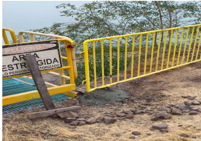
FIGURA 1.49. corresponde a la barrera dura ya instalada
