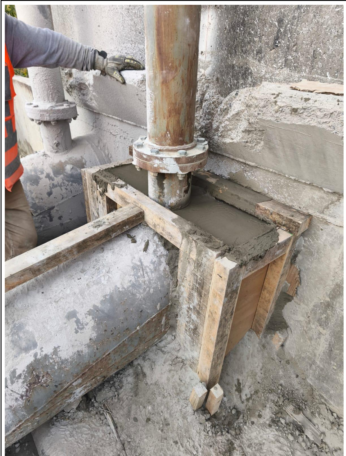
FIGURA 1 .35. corresponde al moldaje ya terminado y entregado
