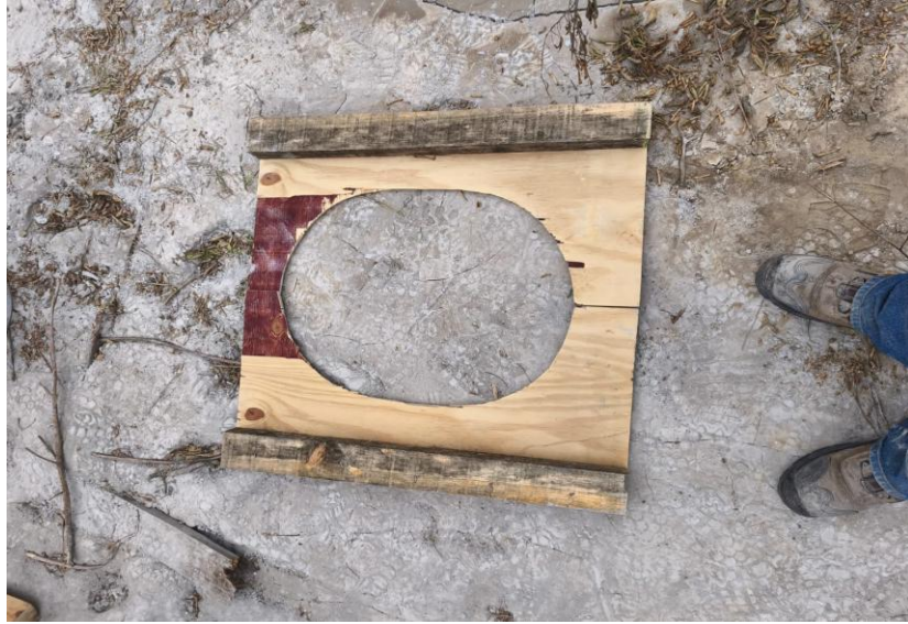
FIGURA 1.32. correspondiente a cara principal del moldaje
