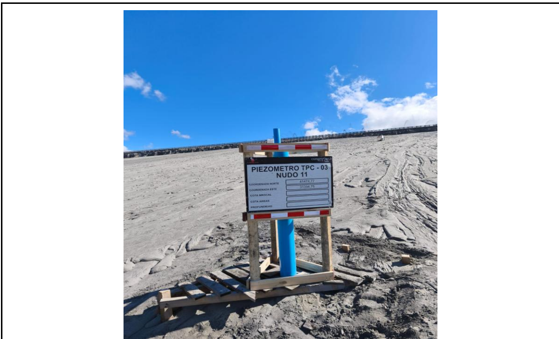
FIGURA 1.45. correspondiente a piezómetro nudo 11 ya terminado
