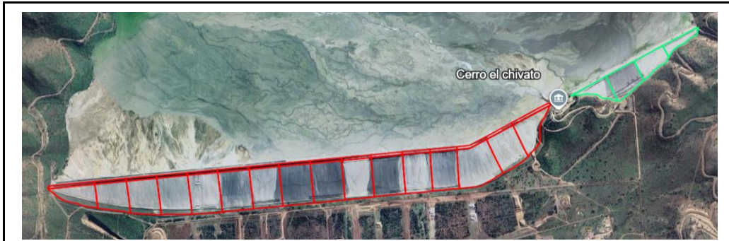
FIGURA 1.6. Imagen representativa del muro de relaves y sus correspondientes nudos, los nudos separados por color rojo corresponden al Muro principal el cual consta de 16 nudos, y los separados por color verde corresponden al Muro Este los cuales son 4.
