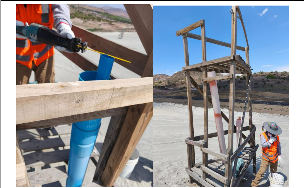
FIGURA 1.54. correspondiente a el rebaje de tubos de PVC
