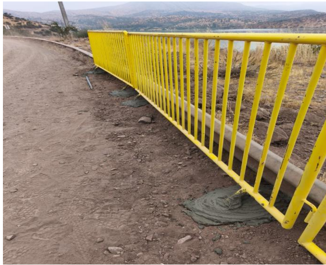
FIGURA 1.50. corresponde a la barrera dura ya instalada
