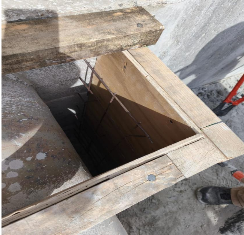
FIGURA 1.34. corresponde al interior del moldaje con la malla ya puesta
