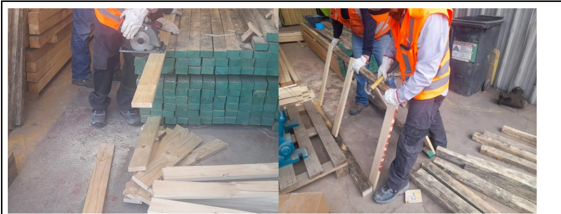
FIGURA 1.36. Correspondiente a procedimiento de fabricación de castilletes para piezómetros
