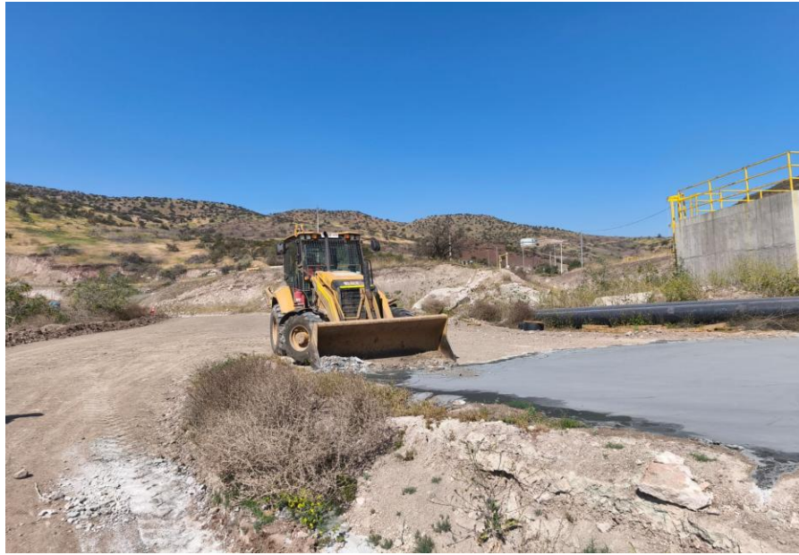
FIGURA 1.25. correspondiente a trabajo en conjunto con retroexcavadora en sensor 12
