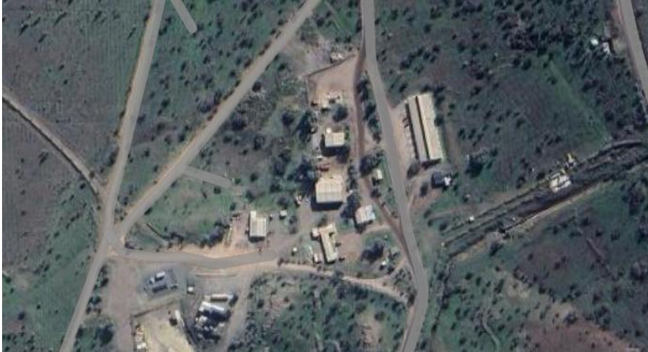
FIGURA 1.3. Esta imagen corresponde a la instalación de faena de SCHWAGER donde se dividen lo edificios entre el personal de OOCC, Mecánicos y eléctricos
