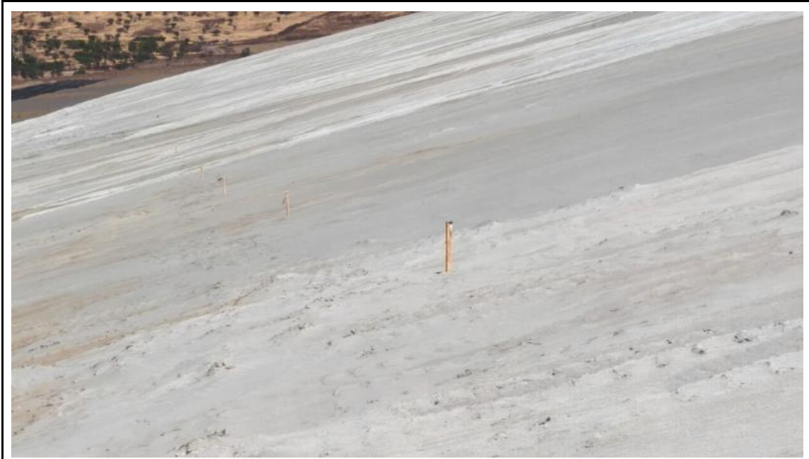
FIGURA .1.12. Imagen correspondiente a la instalación de estacas nudo 8 segundo tercio
