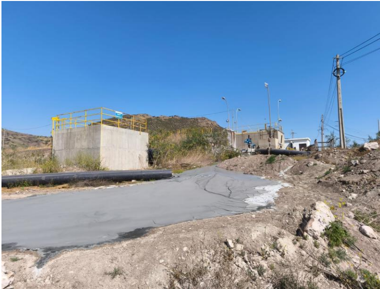
FIGURA 1.24. correspondiente a la filtración de relave cajón N°1 derivación N°3
