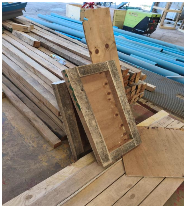
FIGURA 1.30. correspondiente a la fabricación de los laterales del moldaje
