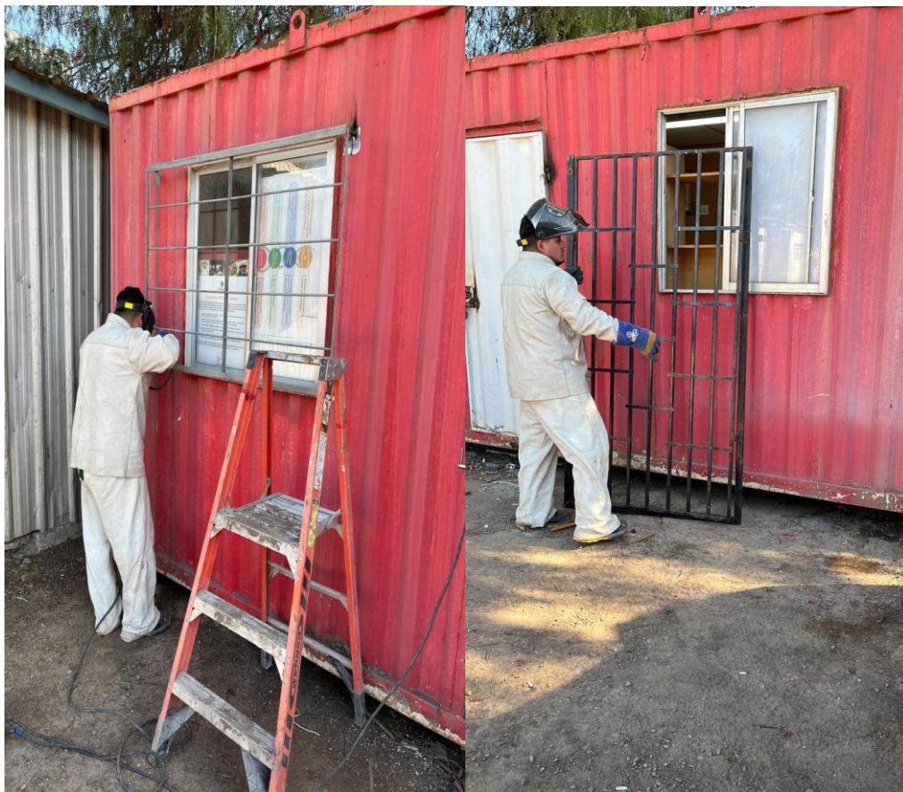
FIGURA 1 .57. correspondiente a la instalación de protecciones en oficina de O.O.C.C
