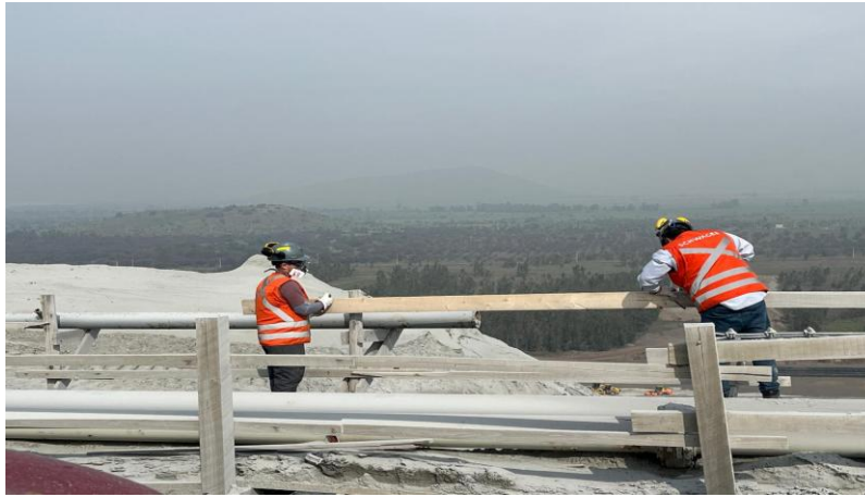
FIGURA 1 .55. correspondiente al cambio de baranda nudo 07
