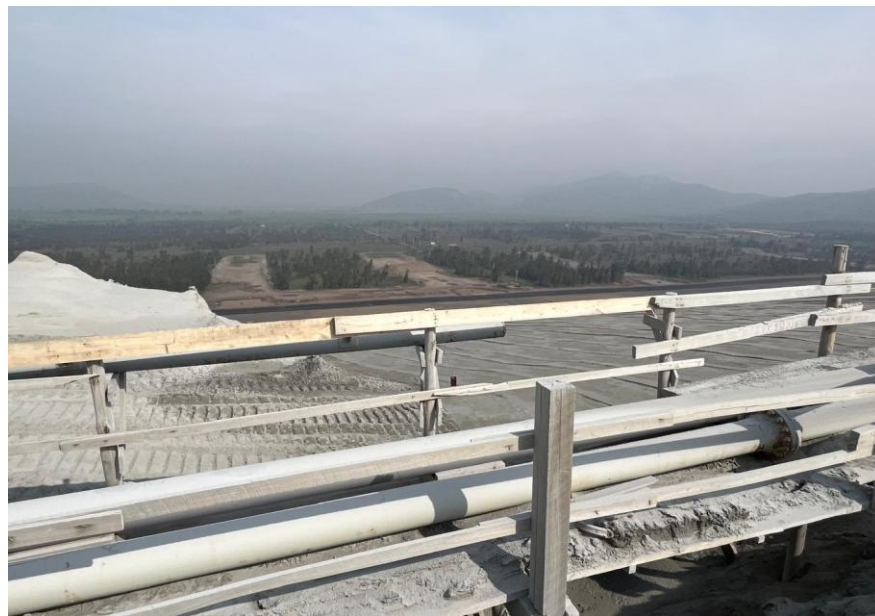
FIGURA 1.56. correspondiente al cambio ya realizado de barandas nudo 07
