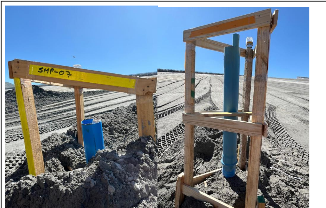
FIGURA 1.46. correspondiente a piezómetro dañado a los pies del muro, antes y después del trabajo realizado
