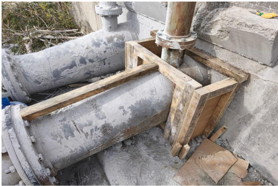
FIGURA 1.33. correspondiente a moldaje ya ensamblado
