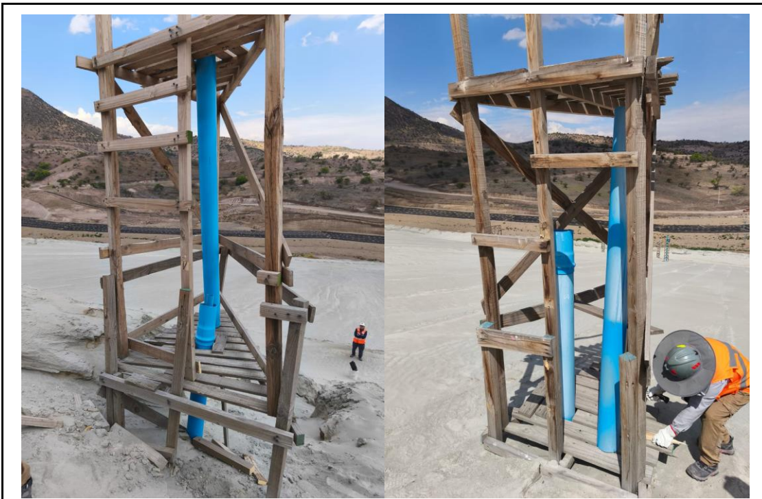
FIGURA 1.53. correspondiente a el rebaje de los tubos de PVC
