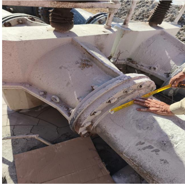
FIGURA 1.27. correspondiente a la toma de medidas para poder realizar el moldaje
