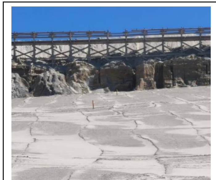
FIGURA 1.13. Imagen correspondiente a instalación de estacas nudo 8 segundo tercio
