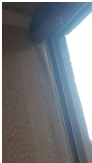
Figura 75: Soplado de papel mural en borde de ventana dormitorio depto. N 155.
