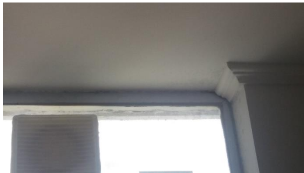
Figura 86: Hongos en cielo de la cocina, arriba de ventana depto. R 469.
