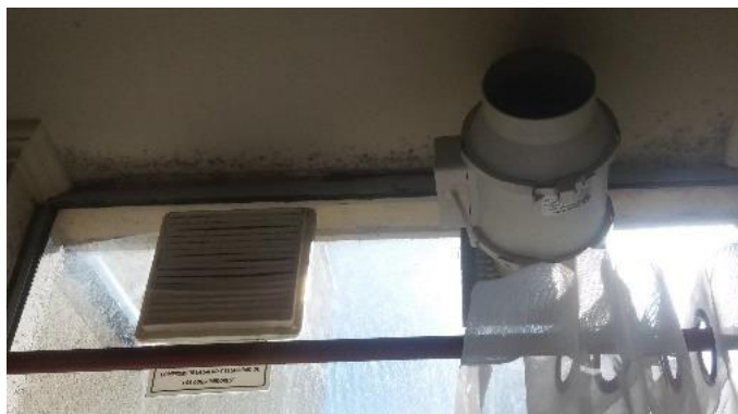
Figura 65: Hongos en cielo de cocina arriba de ventana depto. F 324.
