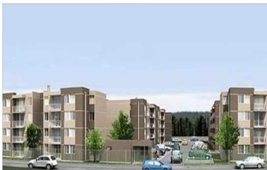
Figura 12: Vista frontal condominio.
