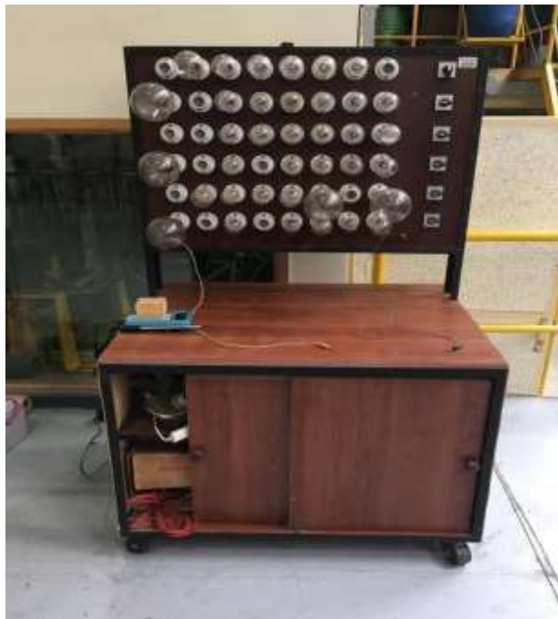
Figura 43: Banco de carga utilizado
