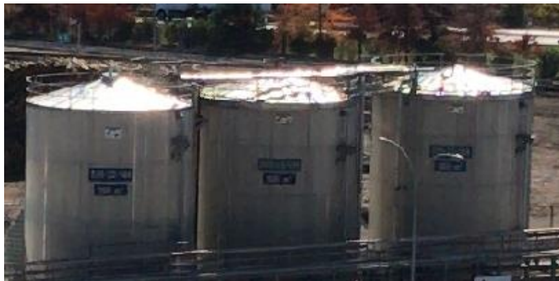
Fig. 2 Tanques techo fijo tipo cónico.
