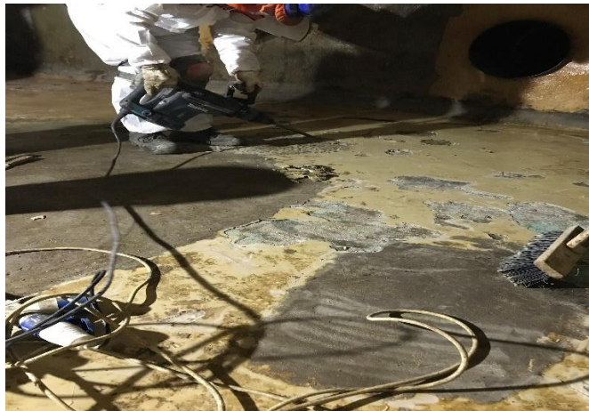
Fig. 29 Inspección de fondo.
