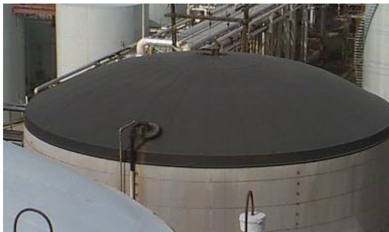
Fig. 3 Tanque techo fijo curvo.
