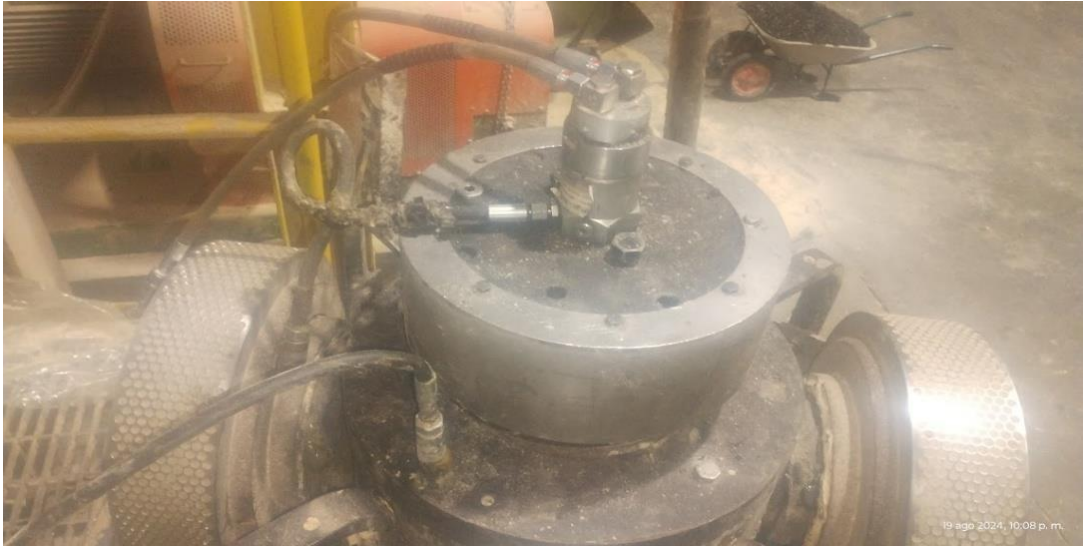
Figura 3-10. Imagen referencia de posición tuerca hidráulica. Fuente: Autoría propia. Imagen registrada desde terreno, en mantención realizada a prensa Kahl.
