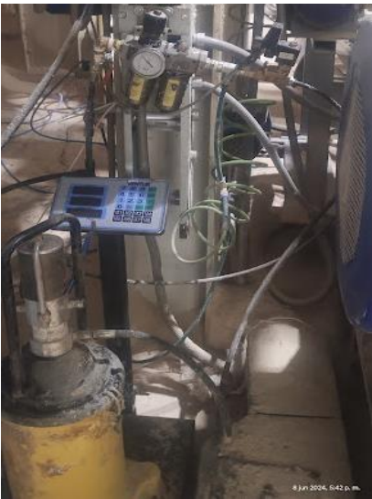
Figura 3-11. Sistema de engrase de rodillos prensa. Fuente: autoría propia. Imagen registrada en terreno.
