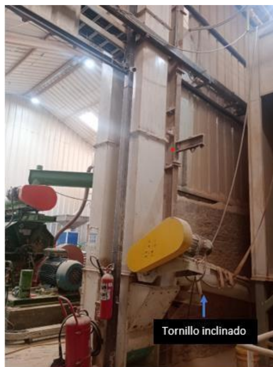
Figura 1-14. Elevador número 2 y tornillo inclinado.
