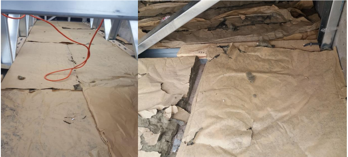
Figura 2-6 Instalación de Lana mineral.
