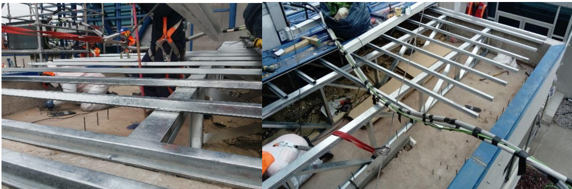
Figura 2-7 Costaneras Instaladas.
