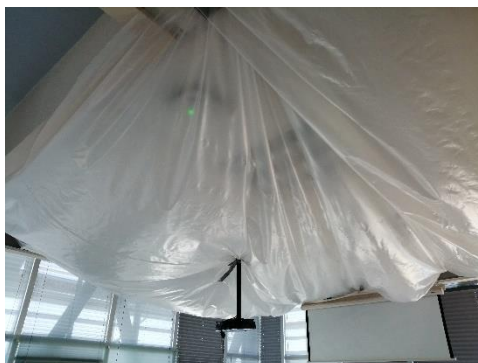
Figura 2-12 forrado con polietileno.
