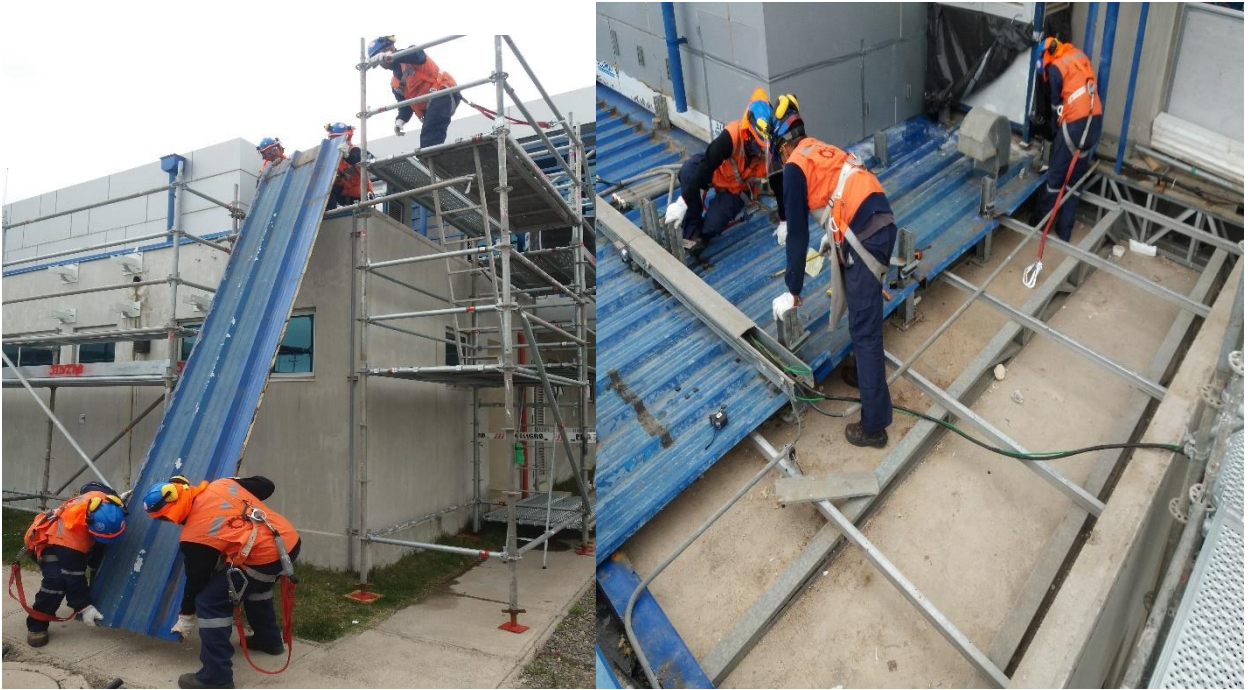
Figura 2-2 Desmontaje de cubierta existente primer piso.
