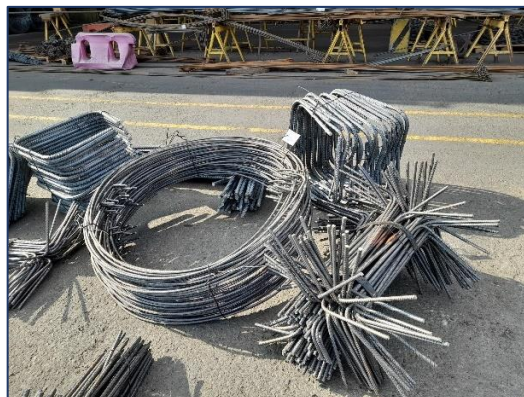
Figura 1-1. Ferralla correspondiente a pilares Edificio Jofre.
