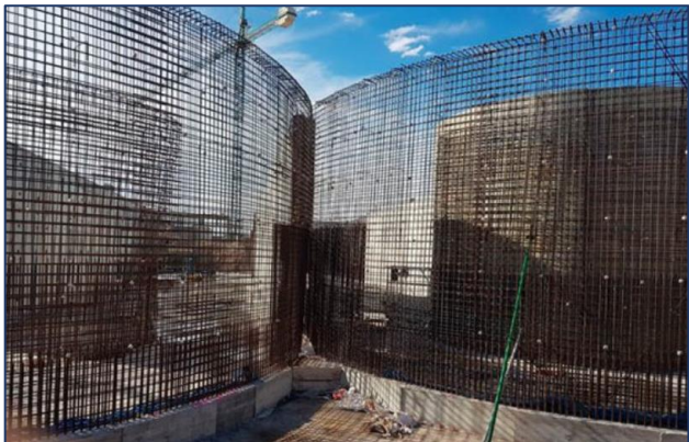
Figura 2-5. Hierro armado en obra.
