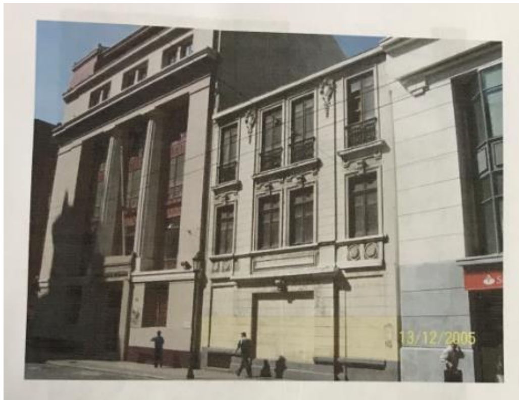
Figura 1-7. Vista del Edificio estudiado, ubicado entre los edificios del Servicio Nacional de Aduanas y el Banco Santander, en Valparaíso, por Calle Esmeralda.
