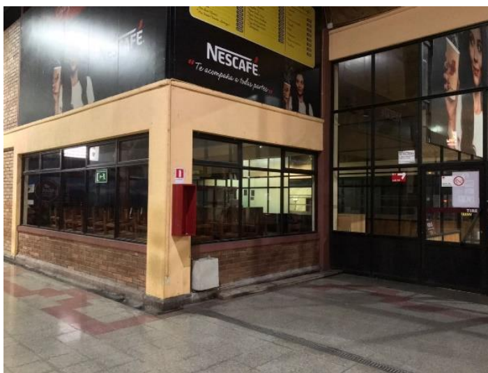
Figura 14: Fachada hacia el andén del restaurant (Elaboración propia)
