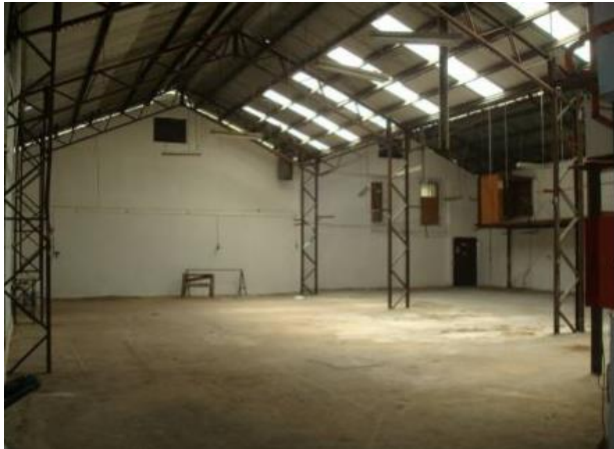
FIGURA5: VISTA INTERIOR OFICINA OPCION N°2. FUENTE: ELABORACION PROPIA.
