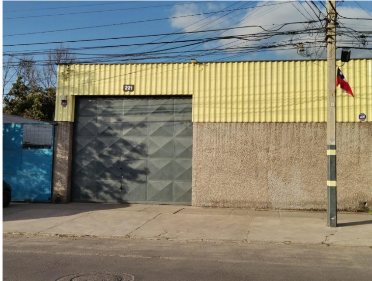
FIGURA 3: VISTA FRONTAL OFICINA N°1. FUENTE: ELABORACION PROPIA.
