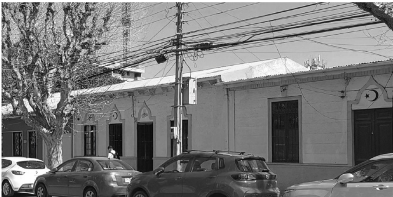
Fotografía fachada casa existentes. Autoría propia
