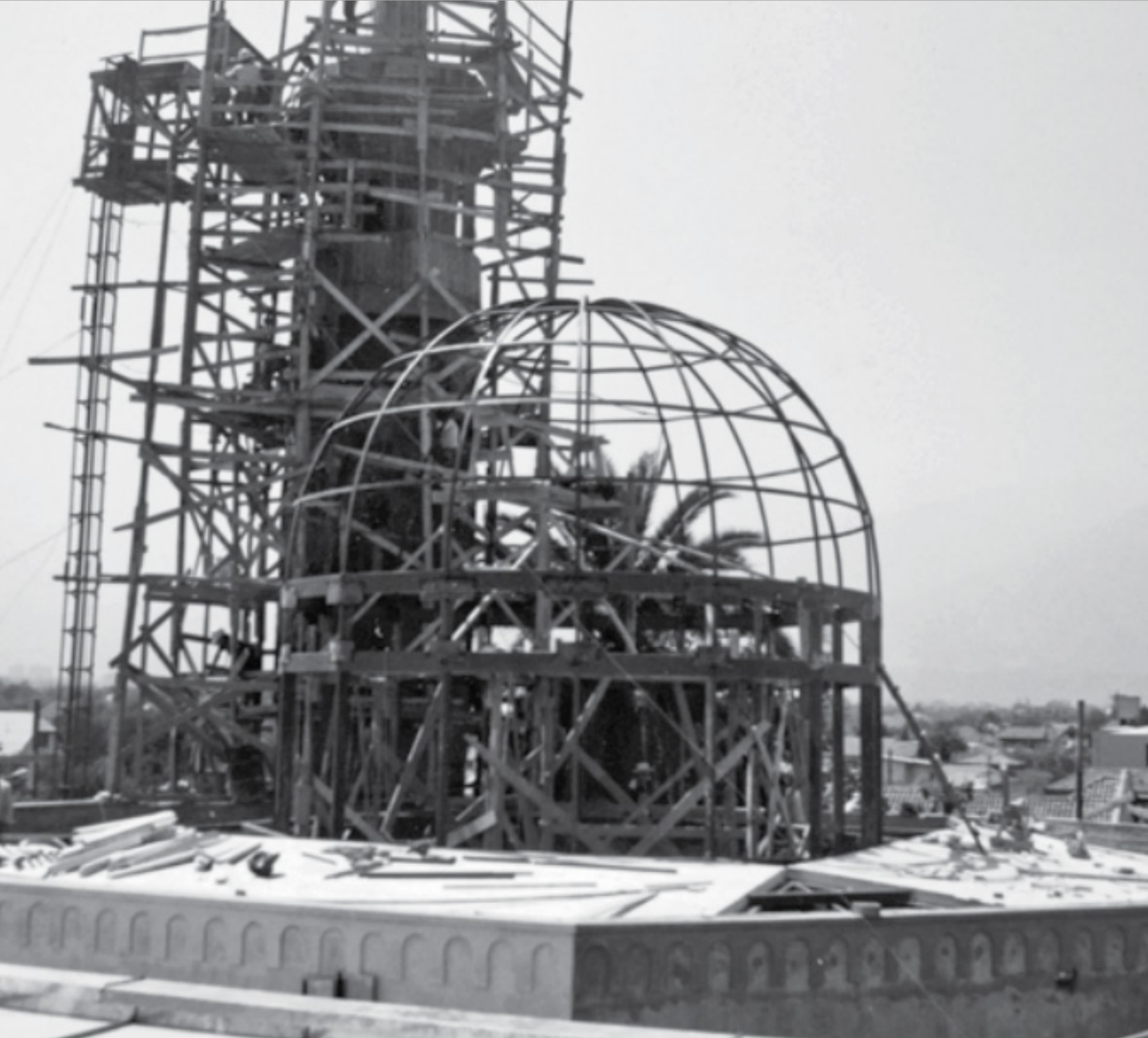
Fotografía del proceso de construcción del primer cúpula islamica en Chile similar a la mezquita AL-Aqsa en Palestina. Autoría Centro islamico de Chile
