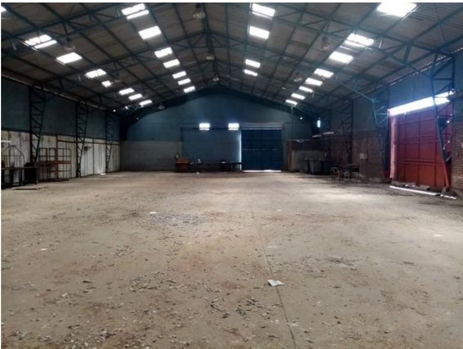
Figura 1-9. En la figura se aprecia el interior del galpón.
