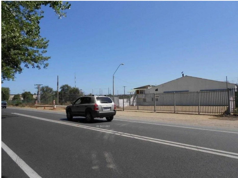
Figura 1-2. Fotografía donde se aprecia el galpón y la Av. Los Manantiales.
