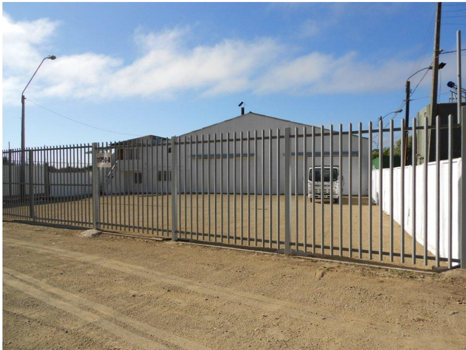
Figura 1-3. Fotografía donde se aprecia la fachada del galpón.
