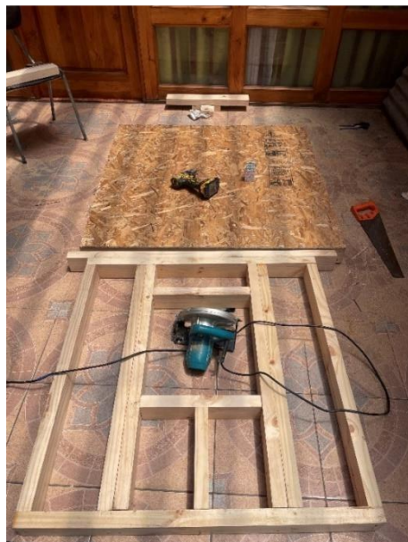
Figura 4.2, Paso 4: Tabiquería.
