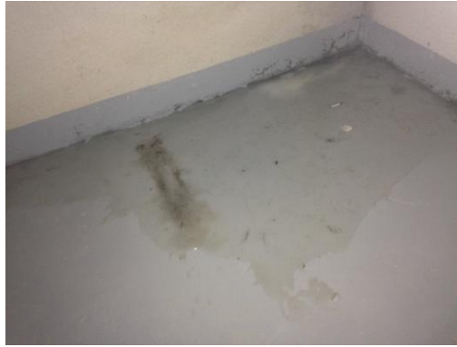
Figura 2-9. Filtración de tubería en sector estacionamiento.
