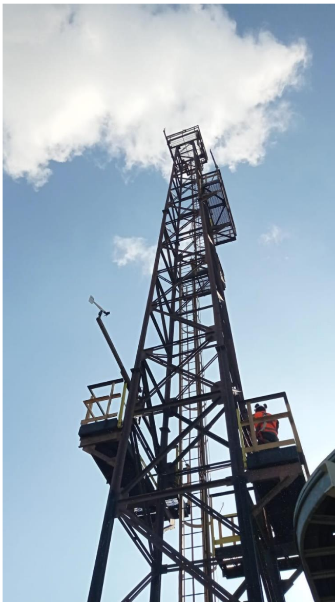
Figura 29 Torre meteorológica ENAP Refinería Aconcagua
