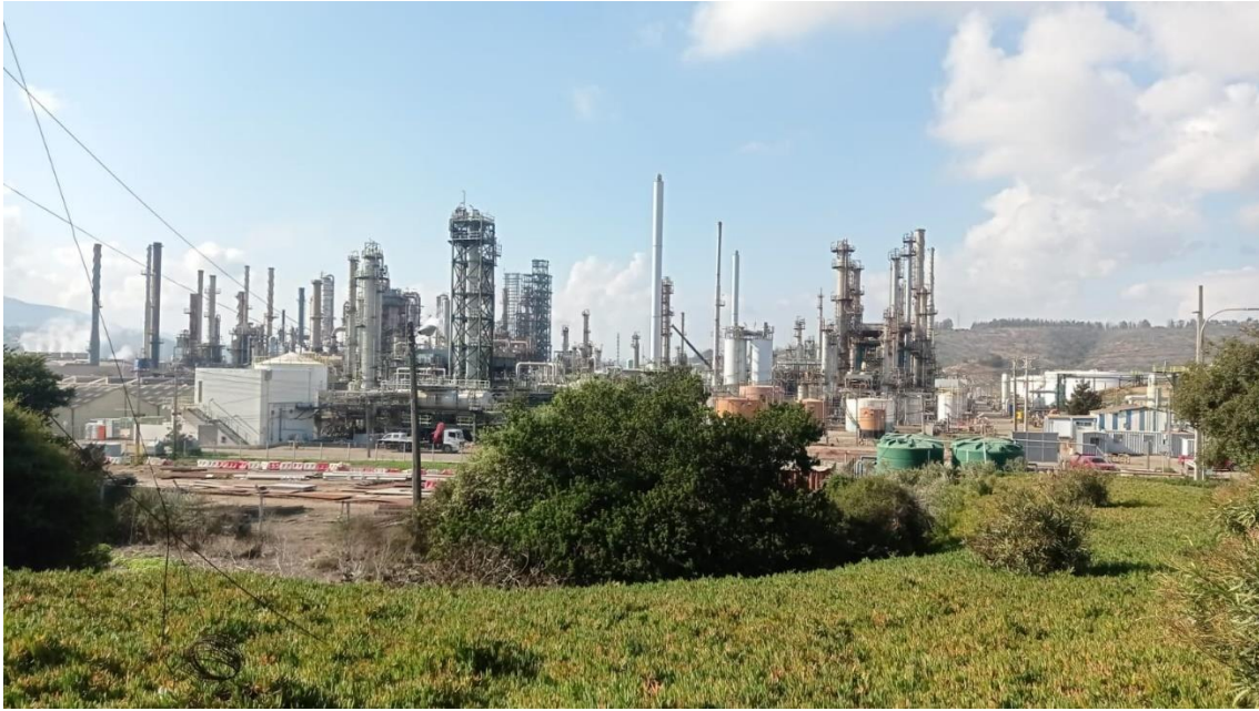
Figura 72 Panorámica de Refinería Aconcagua
