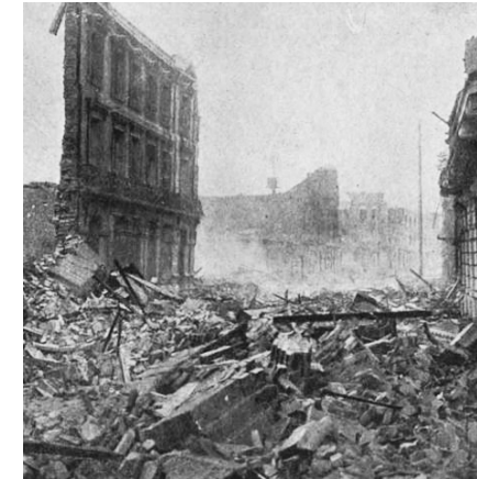
Figura 15: Calle Blanco esquina Edwards, Valparaíso, tras el terremoto de 1906. Fuente: Memoriachilena.cl
