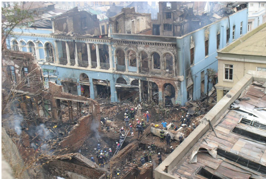
Figura 3: Palacio Subercaseaux en estado ruinoso producto de la explosión de gas e incendio en Calle Serrano, pleno Centro Histórico. Fuente: (Bomba2.cl, 2011).
