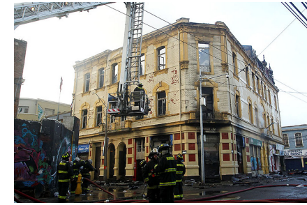
Figura 42: Incendio edificio La Española, 16 de mayo de 2016. Fuente: Emol.com.
