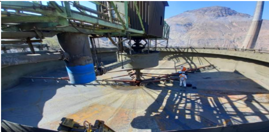
Imagen N°46 “Espesador en mantención”
