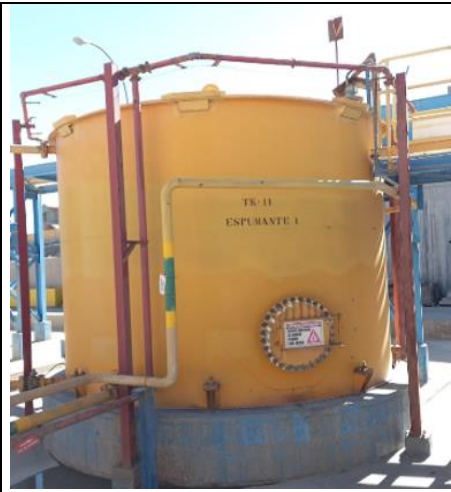
Imagen N°79 “ Vista Frontal estanque”
