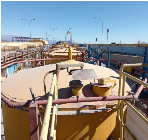
Imagen N°81 “Zona superior estanque”
