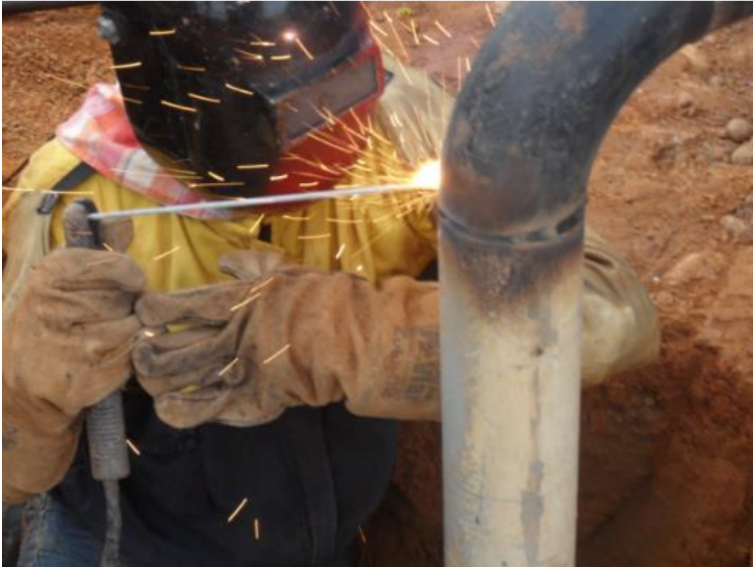
Ilustración 16, Ilustración Descripción Operativa Proceso Smaw
