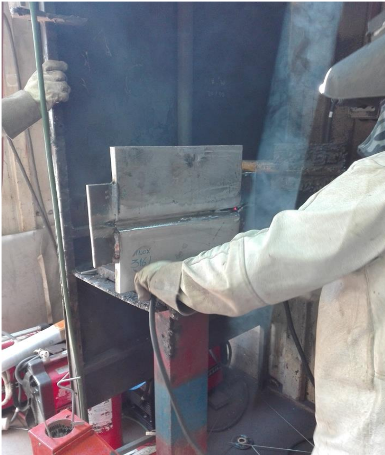
Ilustración 21, Soldador Calificando en WPS: WSM-8/8-1055
