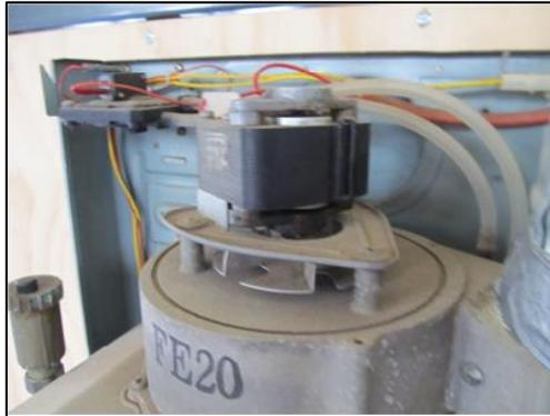
**Figura 3.8:** Ventilador de tiro forzado usado para aumentar el tiraje de los gases de escape.
