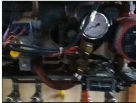
**Figura 3.2:** Manómetro de baja presión instalado en la caldera.
