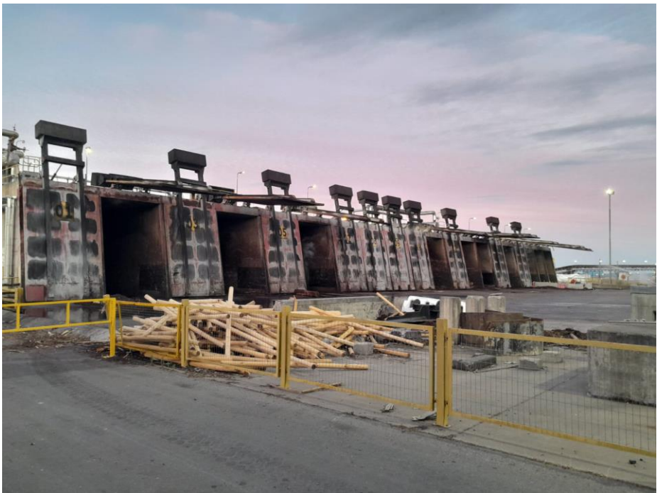
Ilustración 2- 2: túneles de macerado
