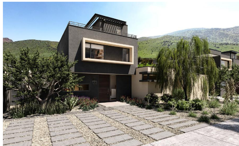
CONDOMINIO MIRADOR PIEDRA ROJA - EN CONSTRUCCIÓN
