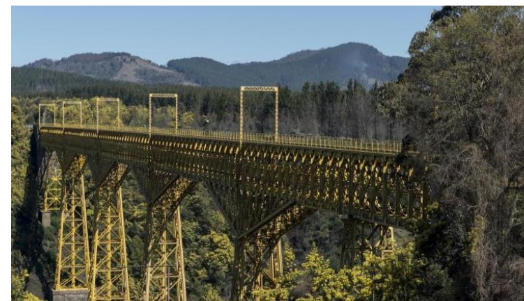
Figura 6: Viaducto del Malleco - Fuente: CMN
