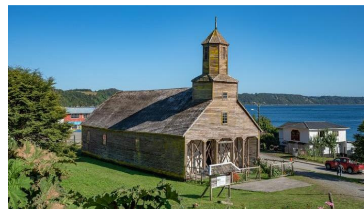
Figura 9: Iglesia de Detif - Fuente: CMN
