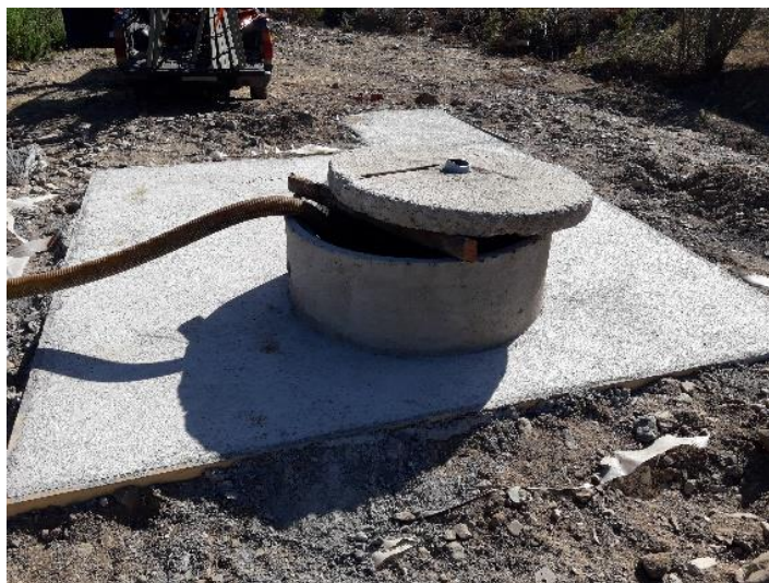
Figuras 2-22. Construcción del pozo y sello para evitar contaminación.
