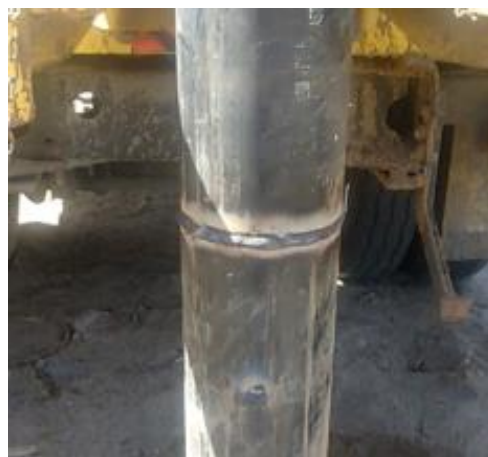
Figuras 2-17. Proceso de unión entre tubos con soldadura al arco.
