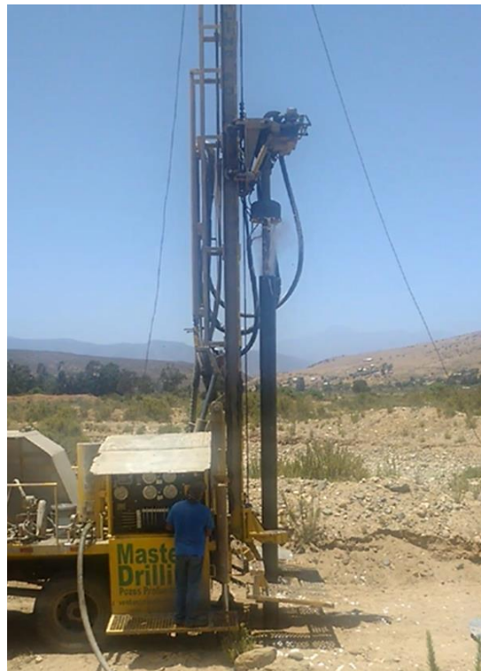
Figuras 2-16. Procedimiento de encaje y perforación del primer tubo.
