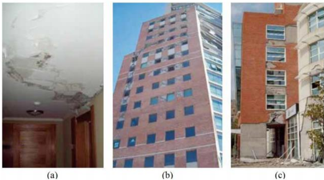
Figura 2.5: Losa de acople y falla por corte
