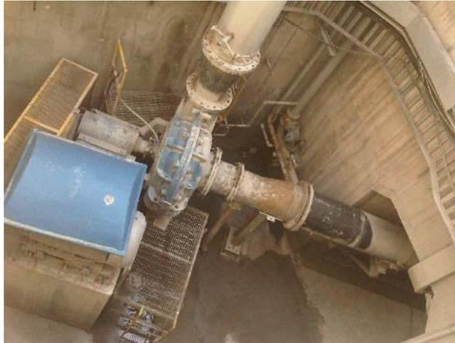
**Figura 1.22, Bomba Warman 18x16x36 descarga espesador.**
