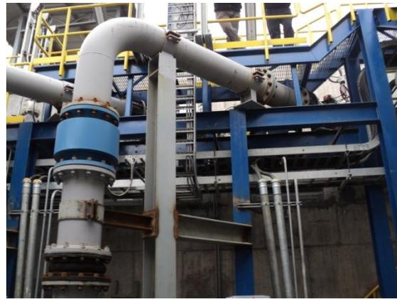
Figura 1.28, Línea descarga bomba RABI
