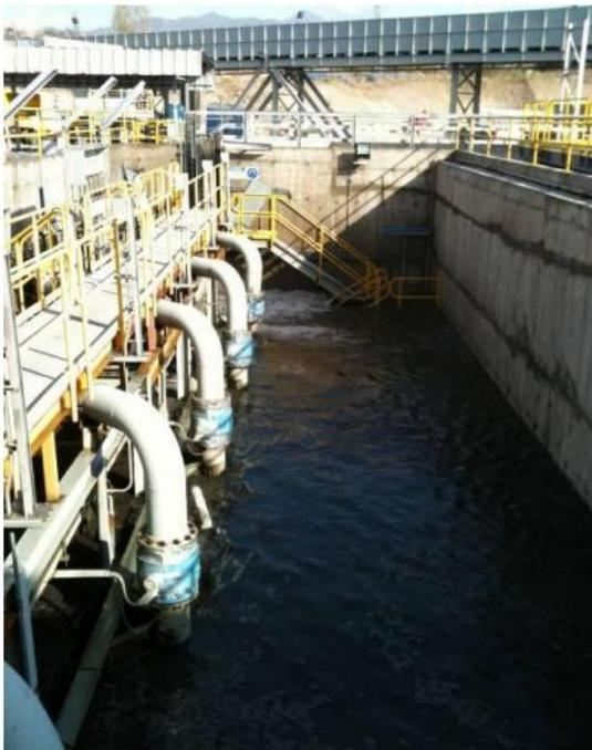
Figura 2.1, Sala de bombas N°1 posterior al colapso válvula guillotina línea de descarga bomba RABI 1
