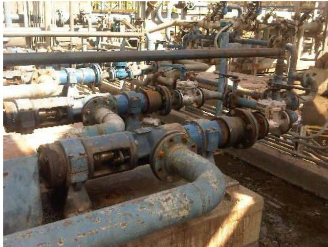
**Figura 1.23, Bombas cavidad progresiva alimentación floculante a espesadores de relave.**
