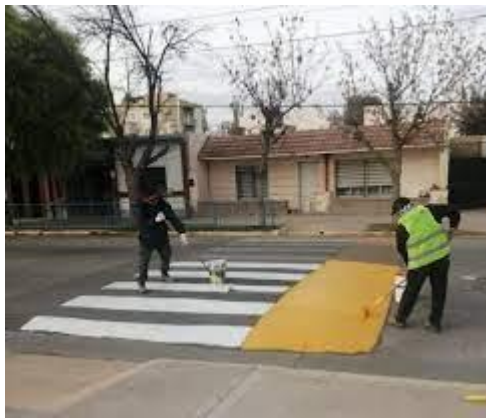
Figura 2-9. Trabajo demarcación
