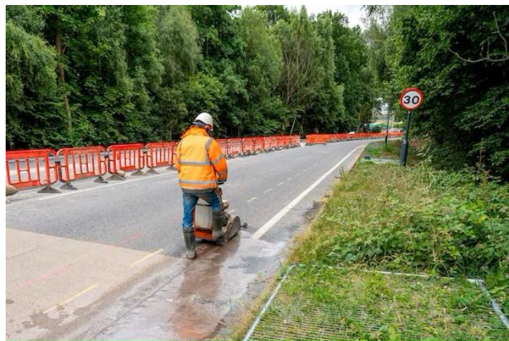
Fuente: Ministerio de obras públicas MOP.
