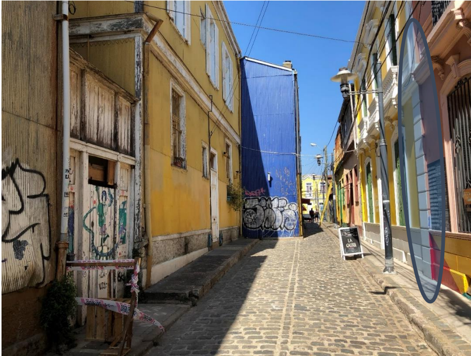
(2) Pasaje Templeman (Fotografía propia)
