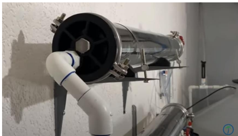
Figura 28: Membrana de ósmosis inversa de 4x40 pulgadas situada en rack de sistema de lavado.
