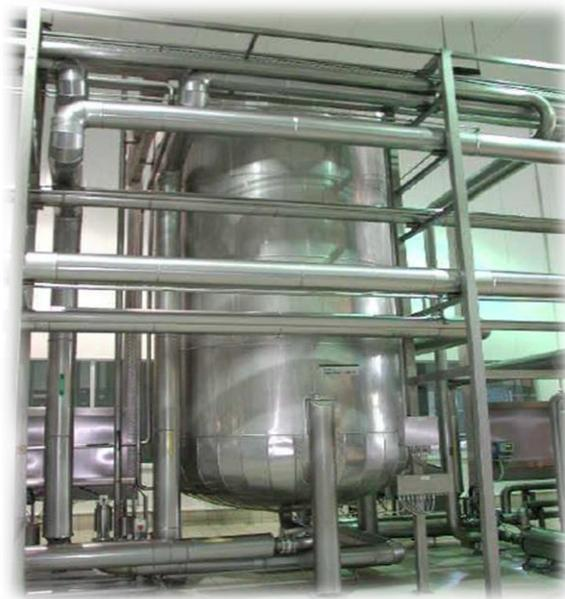
**Figura 9.** Tanque Buffer de alimentación a filtro de tierras. Fuente: Planta de elaboración CCU Temuco, 2018
