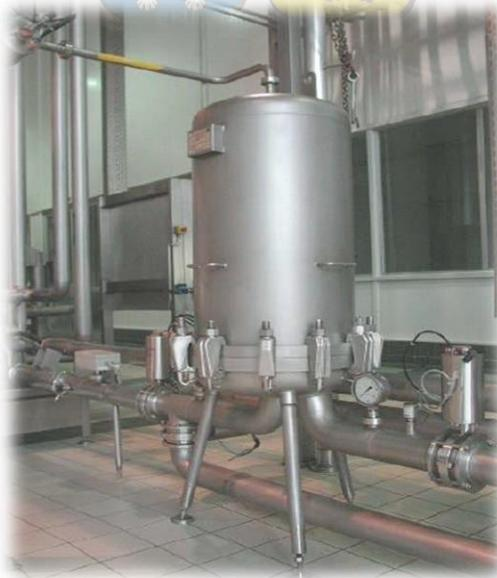
**Figura 14.** Filtro tamiz (filtro pulidor). Fuente: Planta de elaboración CCU Temuco, 2018
