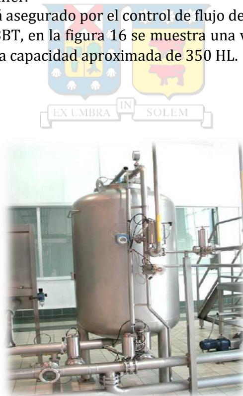
**Figura 16.** Tanque Buffer de cerveza filtrada. Fuente: Planta de elaboración CCU Temuco, 2018
