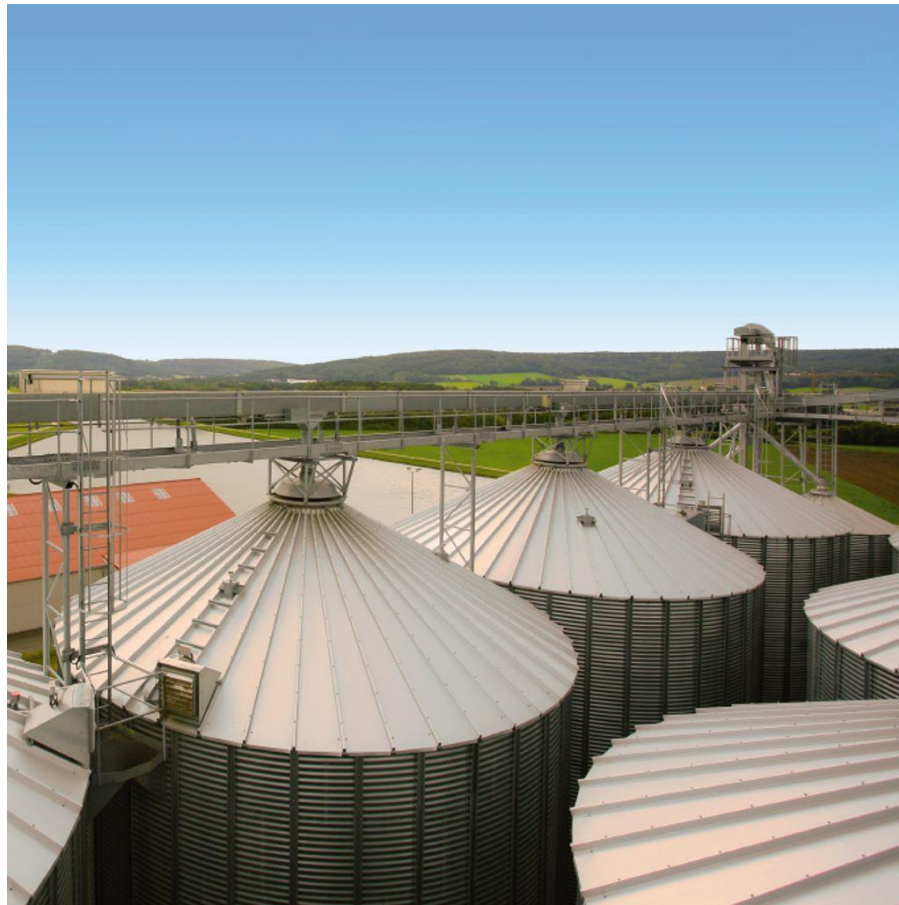
Figura 2.36: Silos de almacenamiento.
