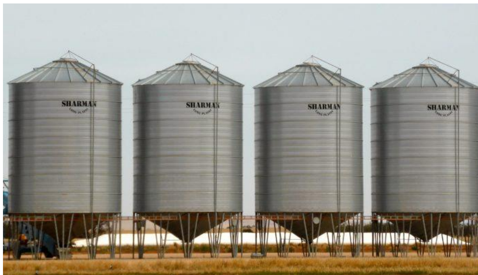
Figura 2.17: Silos de almacenamiento.
