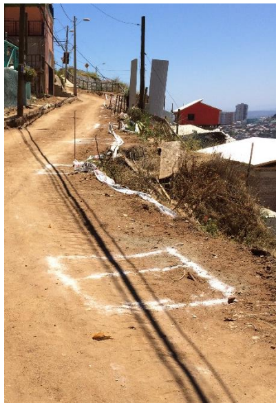
Figura 16. Replanteo de losa.
