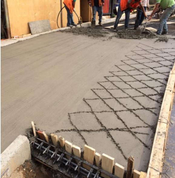
Figura 20. Llenado de losa.
