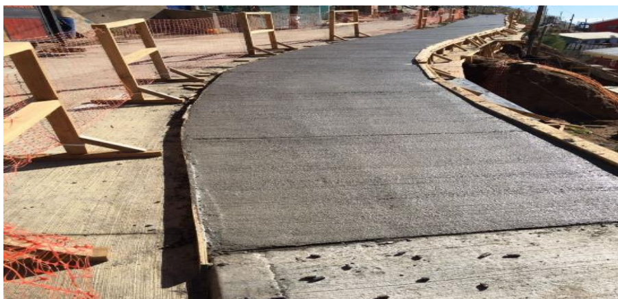
Figura 22. Llenado de sobre losa.
