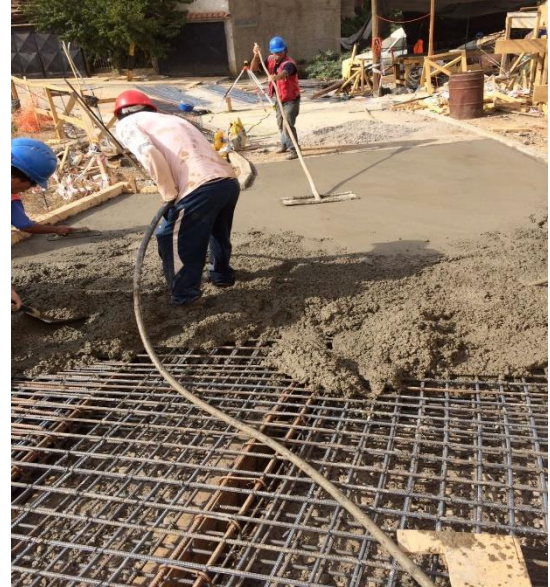
Figura 21. Llenado de losa.
