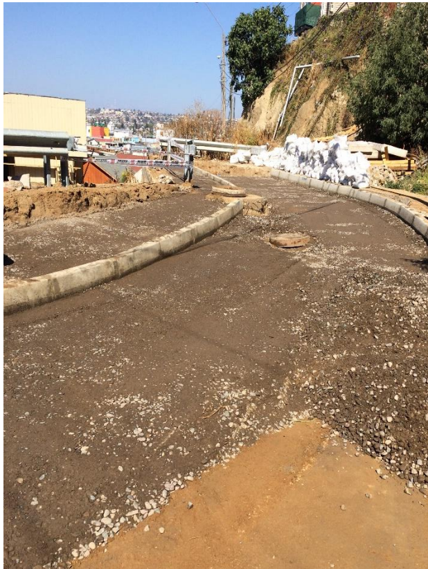
Figura 12. Preparación de sub rasante.
