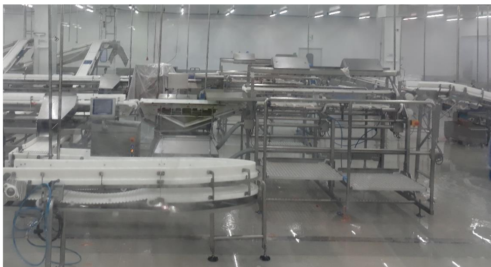
Figura 14: Vista parcial del área de Valor Agregado, en la planta.
