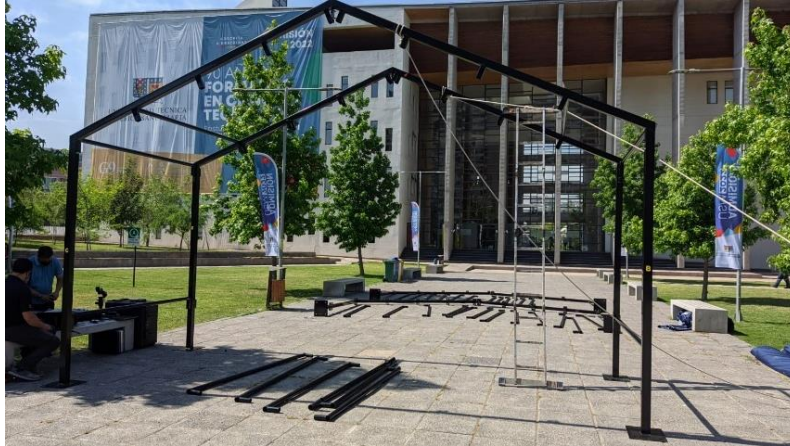
Figura 33: Colocación de correas
