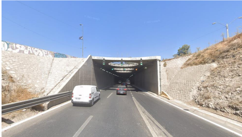
Figura 45: Cambio de via descubierta a subterránea en la autopista Acceso Sur. Fuente: Google Street View [31]
