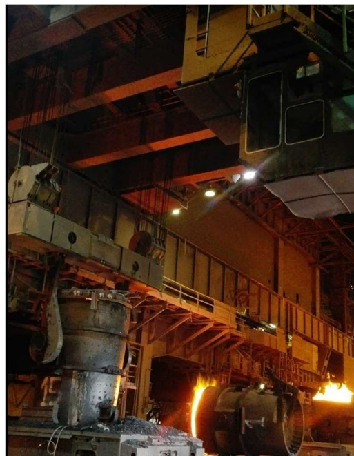
Figura 2- 4: Grúa 22 aérea de 175 ton. Imagen propia
