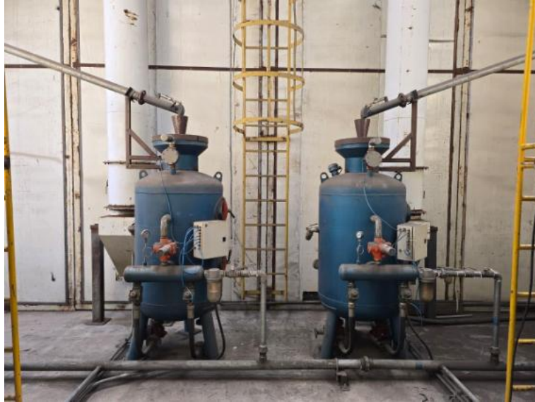
Figura 1-10 Sistema de alimentación de material abrasivo
