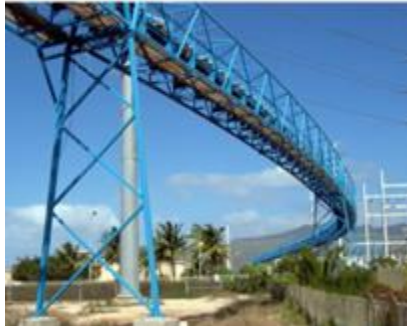
Figura 15: Correa transportadora tipo tubular
