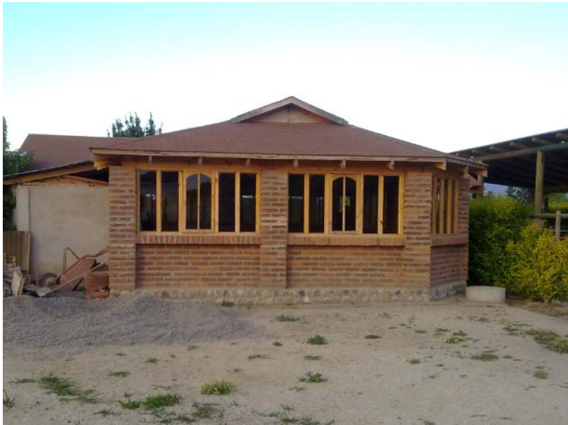
Figura 2-4. Edificación vista lateral para la Escuela de Lenguaje
