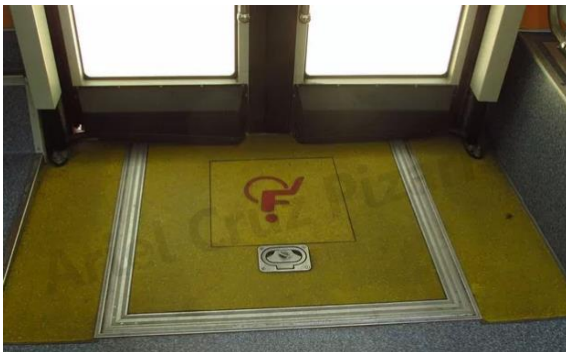
Figura 1-13, Rampa para minusválidos.
