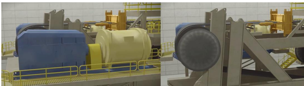
Ilustración 38: Retiro Reductor de Velocidad
