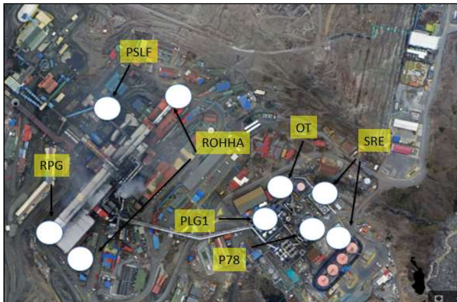
Ilustración N°1: Proyectos en ejecución Fundición Caletones
