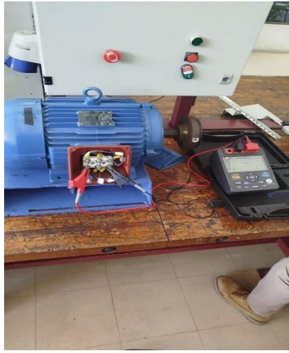
Figura 3-10. Setup implementando para la medición de aislación en motor
