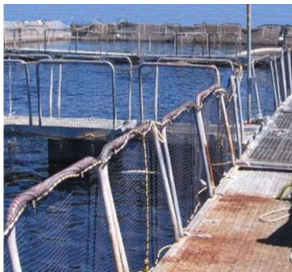
Ilustración 12 Fuente Univ. Austral de Chile - Uso de las barandas
