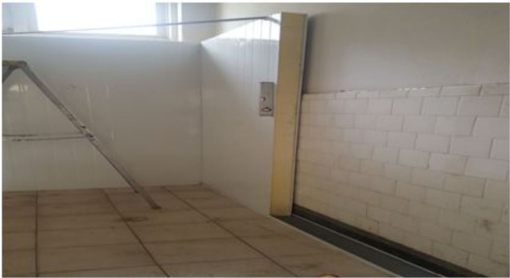
Fuente: Fotografía tomada en edificio Habitabilidad personal soltero Viña del mar.
