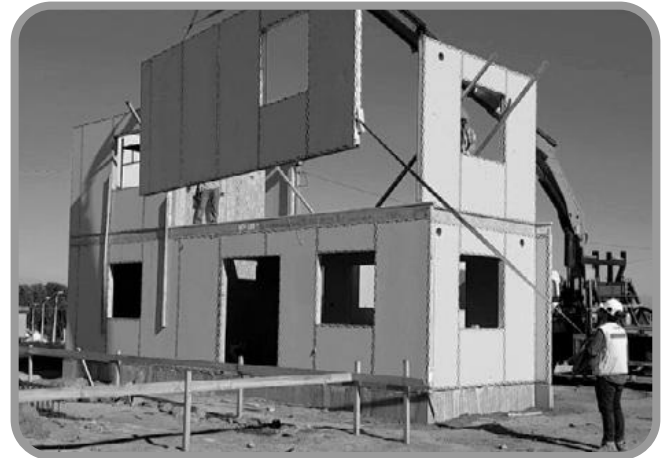
Montaje de panel vertical
