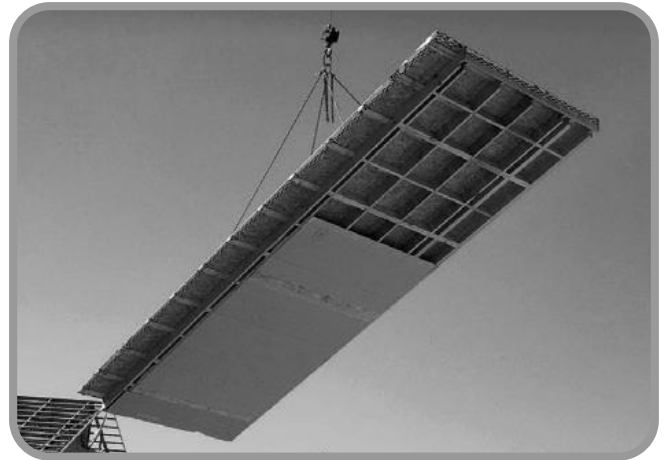
Montaje de panel horizontal
