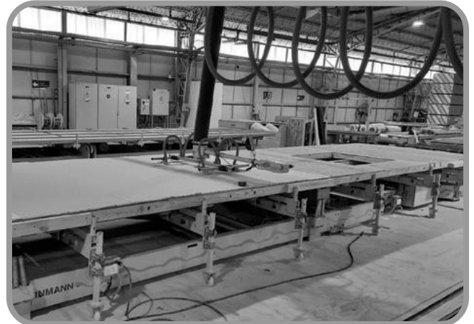
Posicionamiento de placas - estación 3
