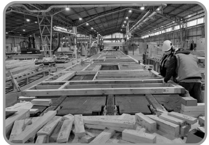
Armado de panel - estación 2
